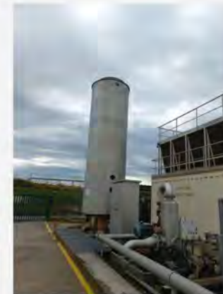
Torchère biogaz relais en cas de dysfonctionnement des unités de valorisation énergétique
