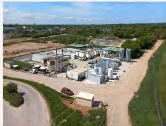
Vue générale de la plateforme de valorisation
