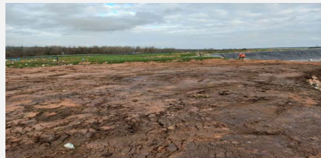
Terrassement préliminaire du casier C 15 -3
