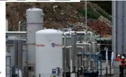
*L'usine de tri et traitement des déchets de la SPEN, au Ham, s'est dotée d'une unité de production de biométhane. Ce gaz non fossile substituable au gaz naturel est redistribué dans le réseau GRDF.*
