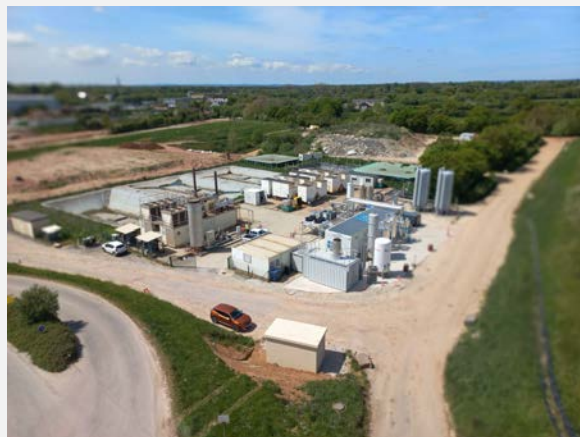
Vue générale de la plateforme de valorisation
